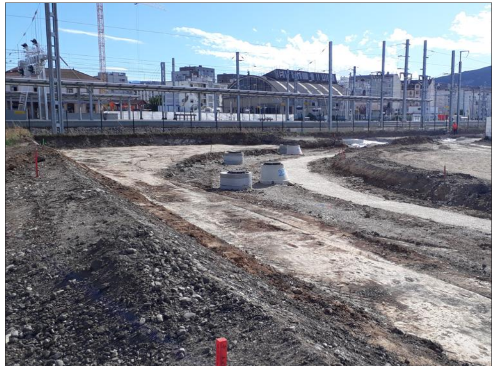
Les travaux du parvis Nord de la gare ont commencé. Depuis le 1 er octobre, rien de très visible à part des travaux de terrassement mais les opérations vont s'enchaîner. Une nouvelle gare visible et en activités avec un accès aux quais dès le 15 novembre. Photo DR
